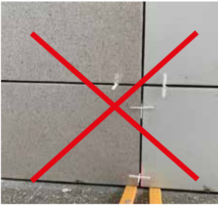
11. ábra: helytelen fugakereszt
